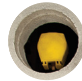
① Can Suyu Vanası
