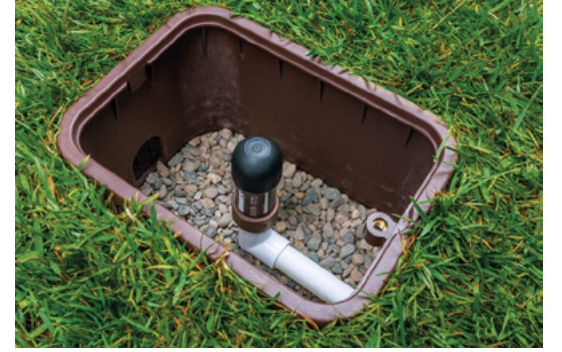
Hava/Vakum Tahliye Vanası Takılı
